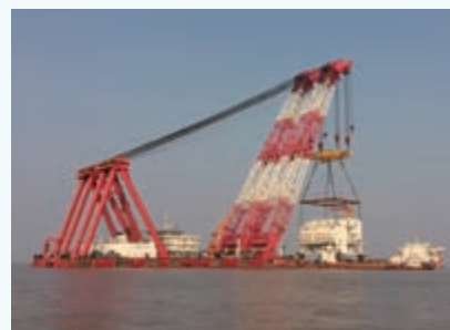
图7 响水升压站安装现场照片
