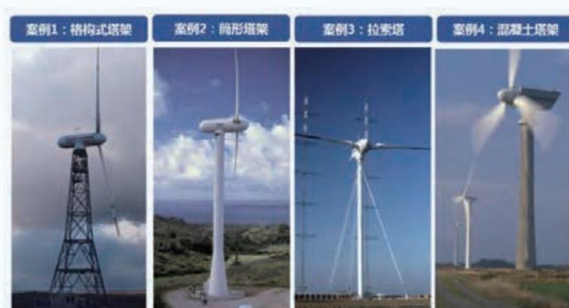
图2 早期风电机组支撑结构案例
