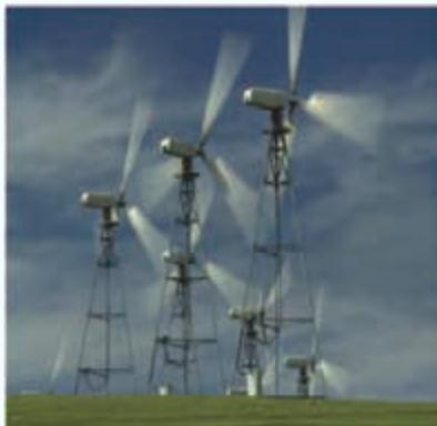
图5 钢格构式塔架（全塔格构式）
