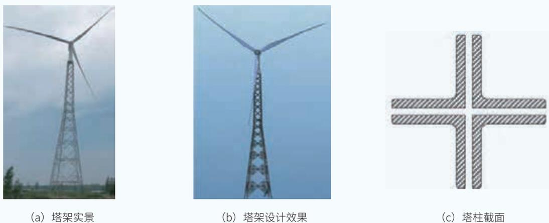
图11 格构式塔架示意
