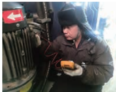
班组成员使用红外测温仪进行场内设备节点测温工作
