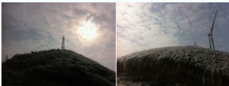
图2 德安某风电场集电线路A10#、A11#塔断线现场
