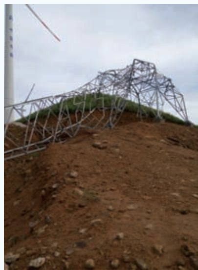
图1 陆丰某风电场集电线路CD45#铁塔倒塌现场
